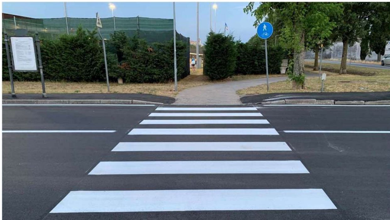
Figura 4 – attraversamento a raso con strisce pedonali
