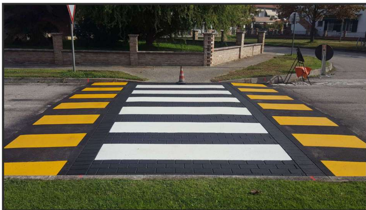
Figura 5 – attraversamento su dosso rialzato
