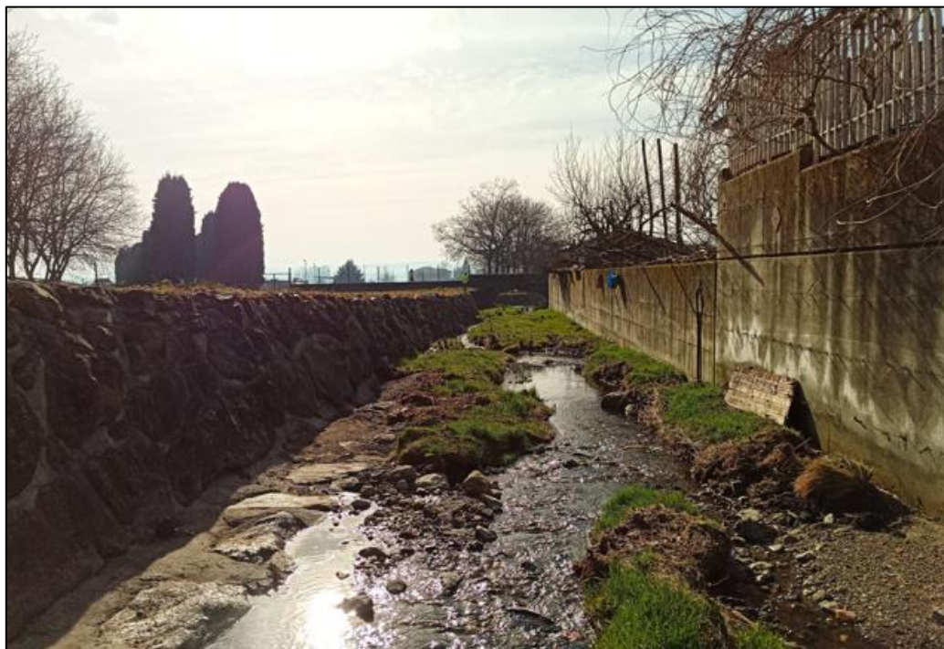
Figura 18. Tratto del rio Morto con muro in c.a. in sponda destra, evidente l'accumulo di materiale.
