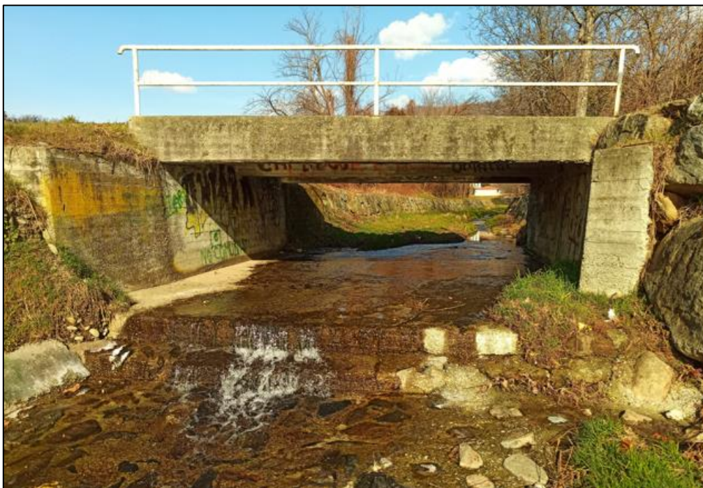
Figura 22. Attraversamento in corrispondenza del cimitero di Bollengo, in evidenza il salto già esistente.
