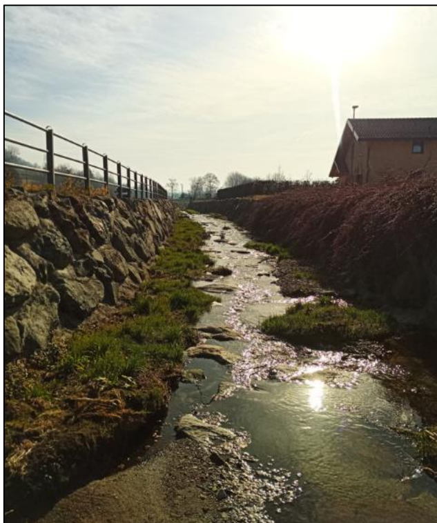
Figura 12. Vista verso valle del tratto di rio Morto già risuolato con massi cementati, dove si riscontra accumulo di materiale.
