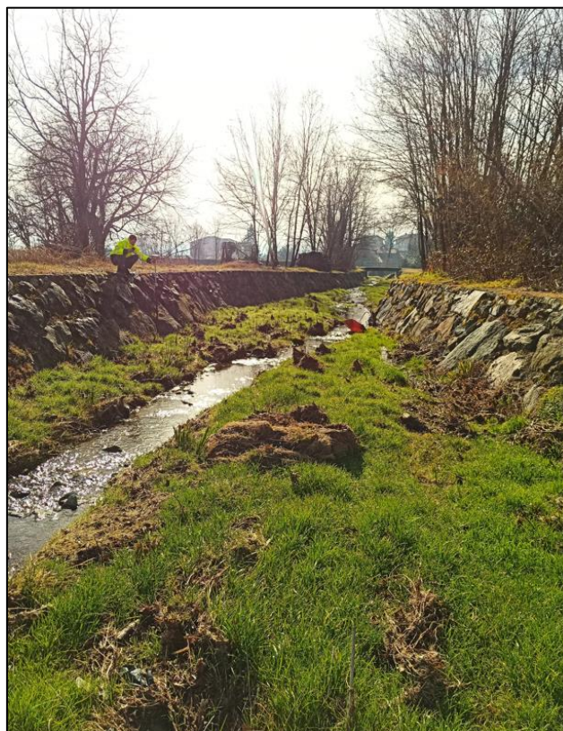
Figura 21. Vista da monte, tratto con doppia scogliera in massi cementati e notevole accumulo in alveo.
