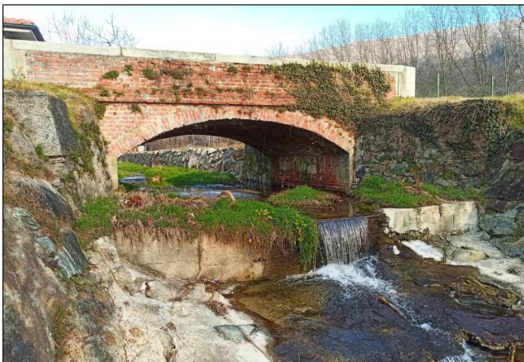
Figura 19. Attraversamento con Strada Bredda, dove si riscontra un salto già realizzato.
