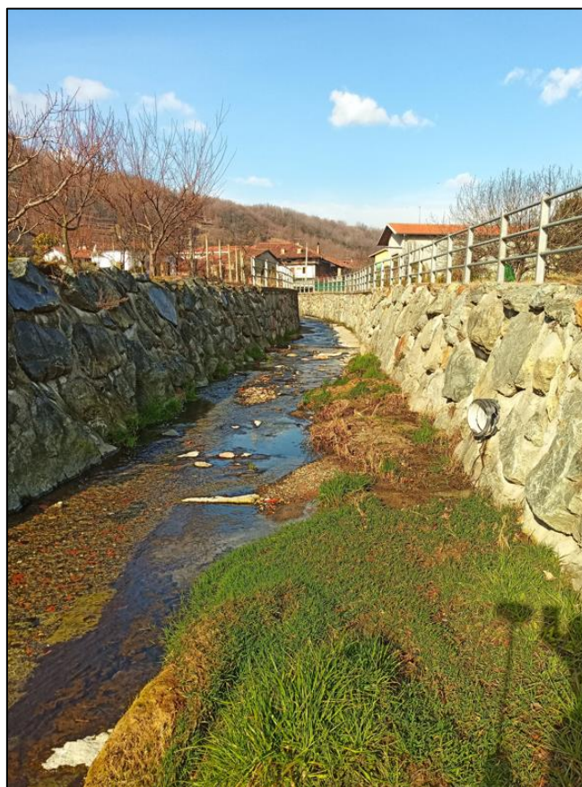
Figura 11: Vista verso monte del tratto di rio Morto già risuolato con massi cementati, dove si riscontra accumulo di materiale.
