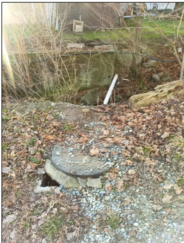
Figura 45. Chiusino e tubazione a vista esistente.
