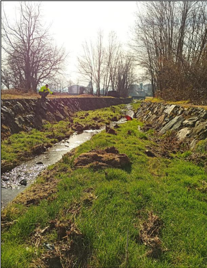
Nota esplicativa: Fig.12_INT.B Vista da monte, tratto con doppia scogliera in massi cementati e notevole accumulo in alveo.
