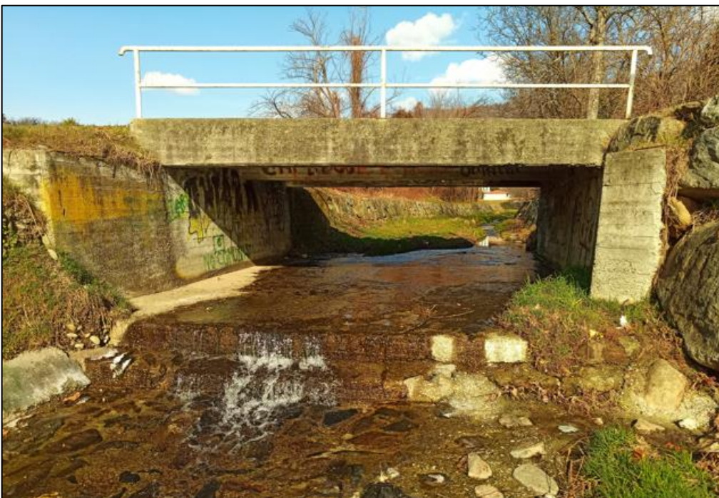
Nota esplicativa: Fig.13_INT.B Attraversamento in corrispondenza del cimitero di Bollengo, in evidenza il salto già esistente.
