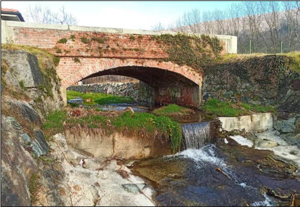
Nota esplicativa: Fig.10_INT.B Attraversamento con Strada Bredda, dove si riscontra un salto già realizzato.
