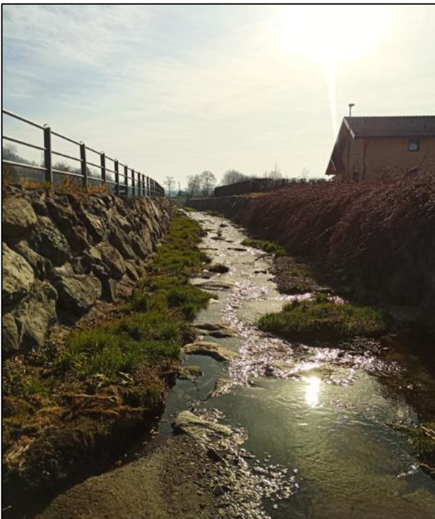
Nota esplicativa: Fig.3_INT.B Vista verso valle del tratto di rio Morto già risuolato con massi cementati, dove si riscontra accumulo di materiale.
