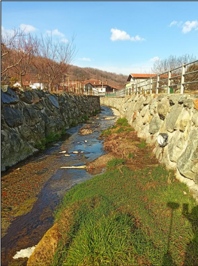
Nota esplicativa: Fig.2_INT.B Vista verso monte del tratto di rio Morto già risuolato con massi cementati, dove si riscontra accumulo di materiale.
