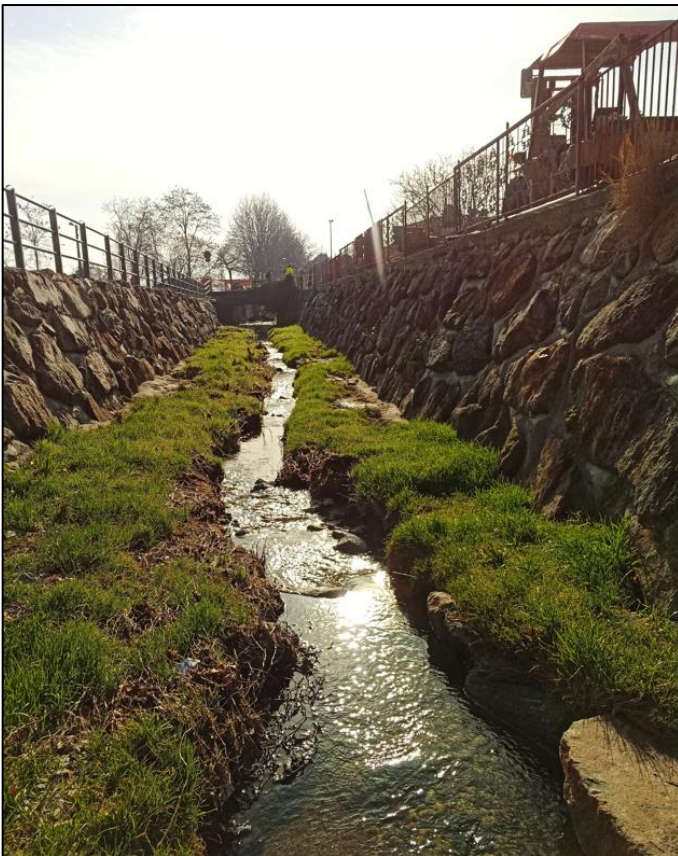
Nota esplicativa: Fig.5_INT.B Rio Morto nel tratto compreso tra due scogliere in massi cementati, accumulo di materiale in alveo, vista verso valle.
