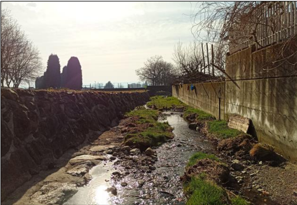
Nota esplicativa: Fig.9_INT.B Tratto del rio Morto con muro in c.a. in sponda destra, evidente l'accumulo di materiale.
